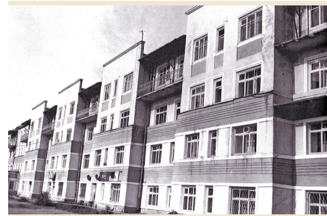
В этом здании на улице Арочная, 41, в 1943–1948 годах размещалось УНКВД по Кемеровской области
